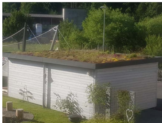
Extensive Dachbegrünung einer Garage
