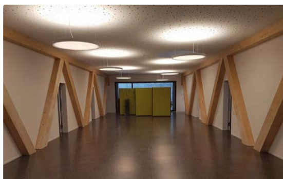
Bürogeschoss zwischen Fachwerkträgern - Linthebene Melioration in Reichenburg
