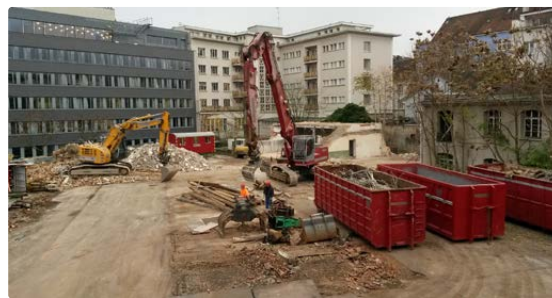
La déconstruction d'un bâtiment est un le moment clé pour le réemploi des matériaux qui en émanent
