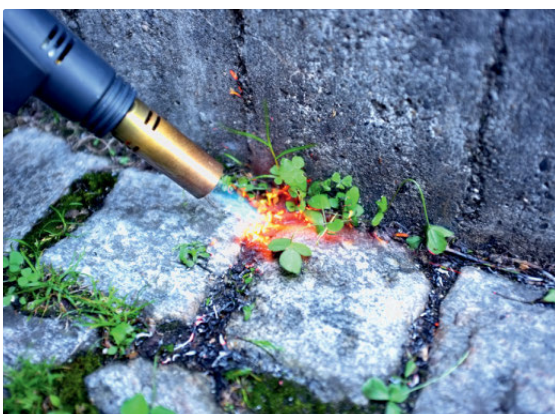
Bearbeitung von Vegetation mit einem Propangasbrenner auf Pflastersteinen.
