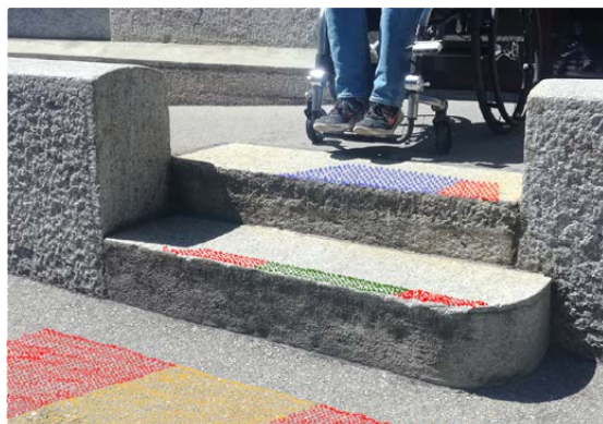
Abgrundsituation, die erkannten Flächen sind farbig darauf gelegt. Rot sind die Punkte ausserhalb des Pfads
