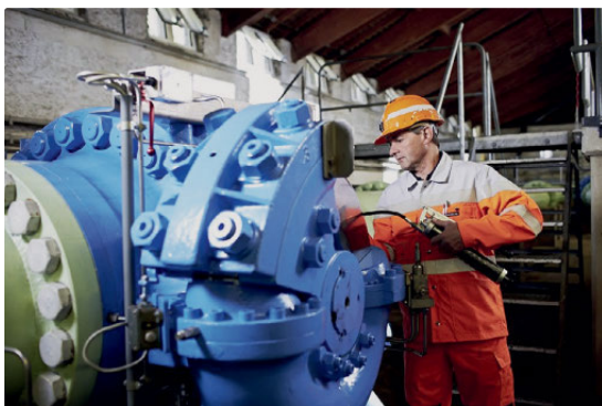
Instandhaltung einer Kraftwerkskomponente
